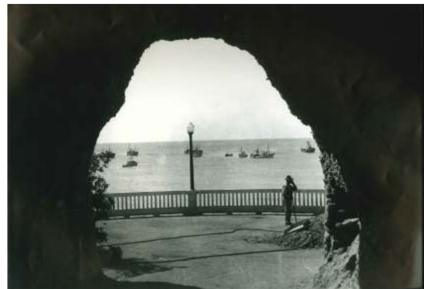
Túnel. Final dos trabalhos de construção. Déc. 30
